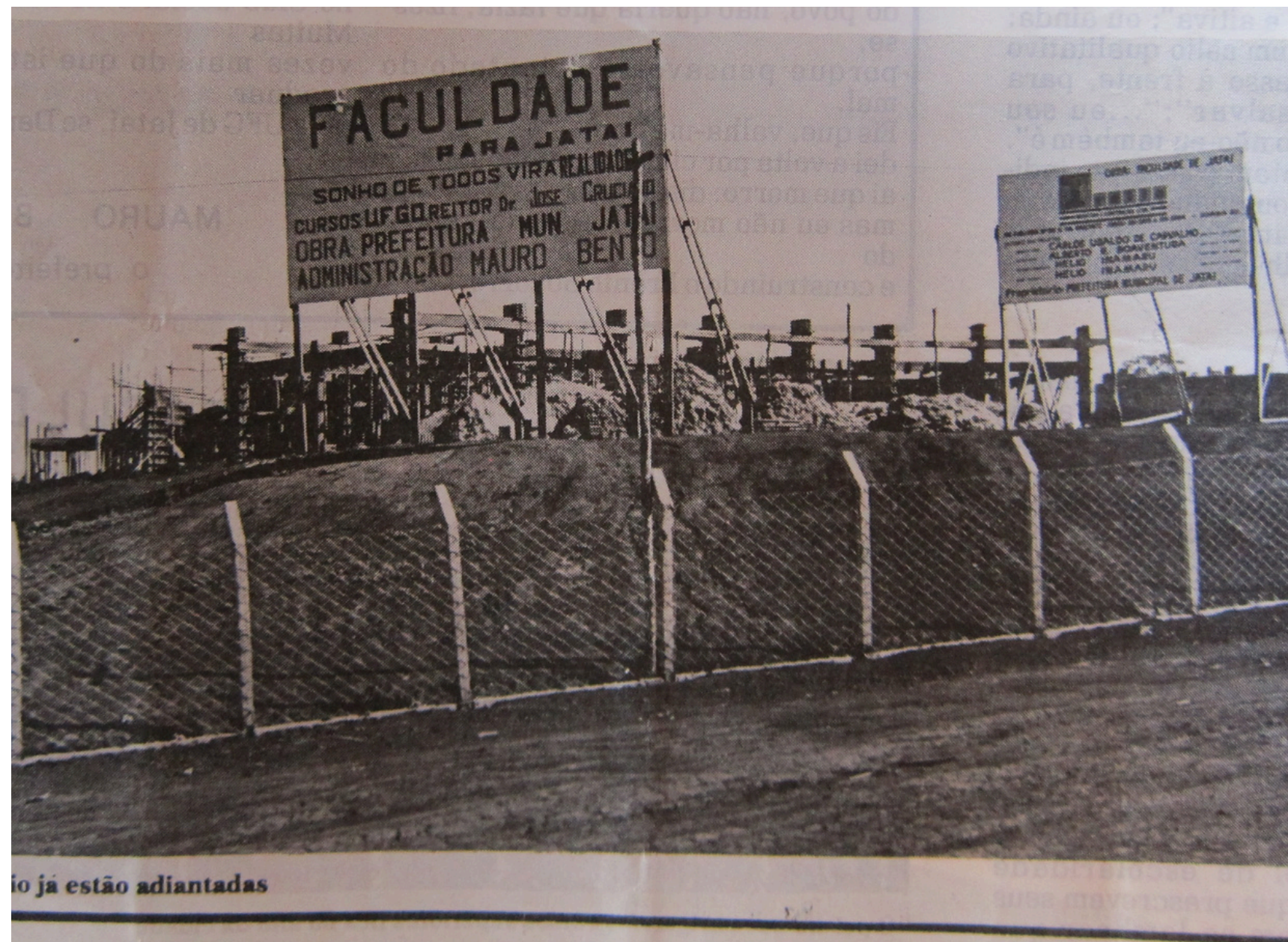
Foto 2 - Obras dos prédios do Câmpus Riachuelo - 1980 Fonte: Acervo Secretaria de Comunicação (SECOM)
