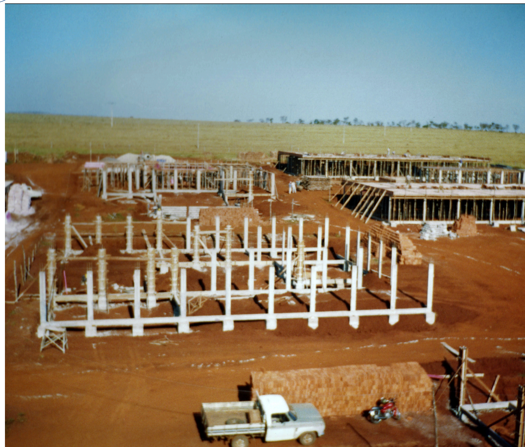
Foto 4 - Construções de Salas de Aulas e Laboratórios no Centro de Ciências Agrárias Fonte: Acervo Secretaria de Comunicação (SECOM)
